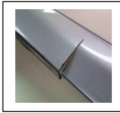
サイトステップ 亀裂部
